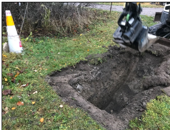
Figur 2-4. Provgropsgrävning, 18GS101.
